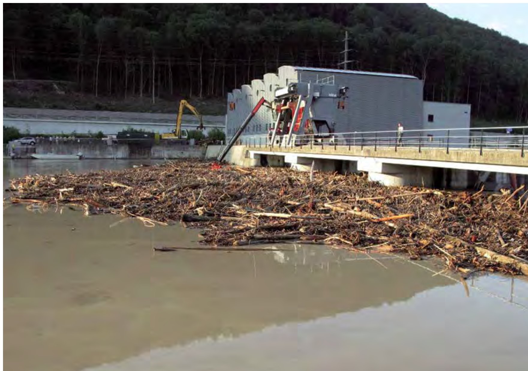
Hochwasser: Zusätzliche Kräne helfen, das Schwemmgut aus dem Einlaufbereich des Kraftwerks zu entfernen.
